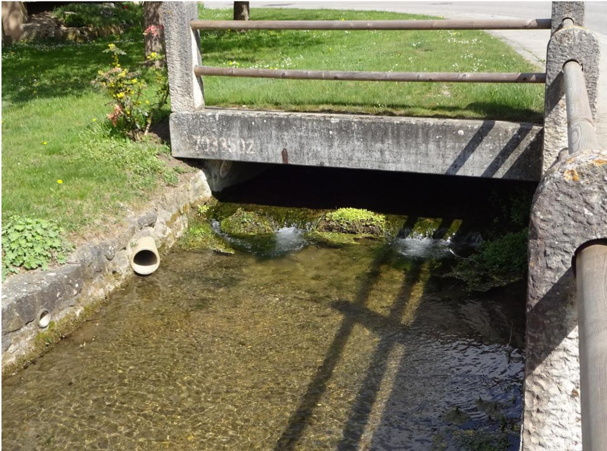
*Hinterbach in Erlingshofen: Ausbau im Betongerinne mit Sohlstufen und streckenweiser Verrohrung*
