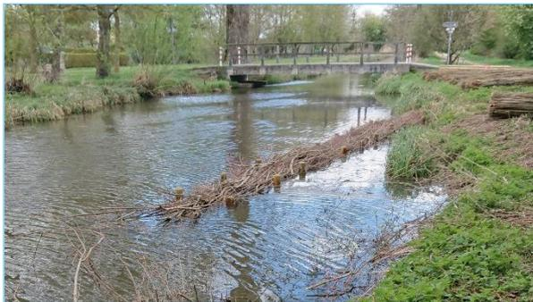
*Bild 8 Einbau von Weidenfaschinen zur Strukturverbesserung*
