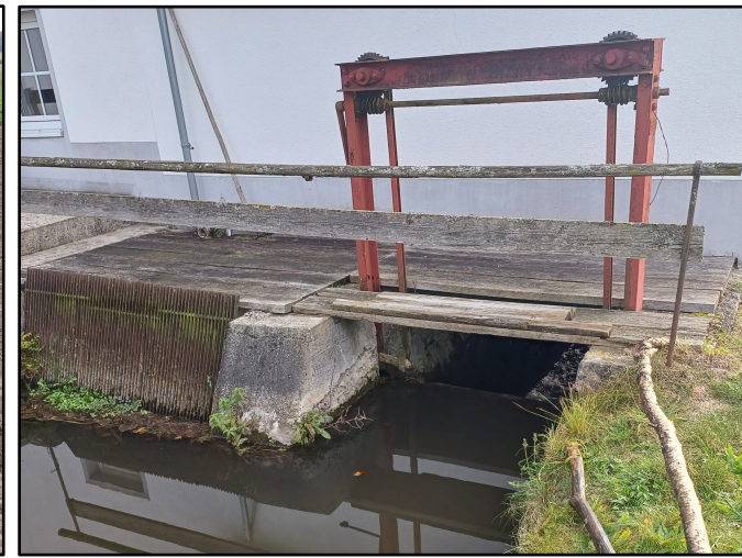
Bild 4 Absturz an Mühle nicht durchgängig
