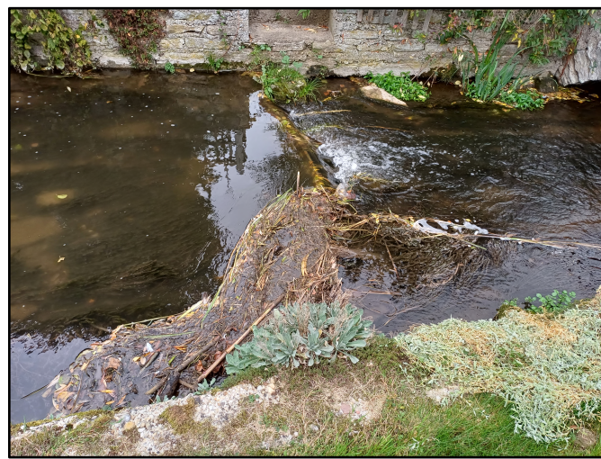
Bild 7 Sohlschwelle nicht durchgängig
