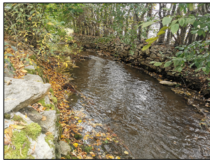
Bild 6 Massive Ufersicherungen (bebauter Bereich)
