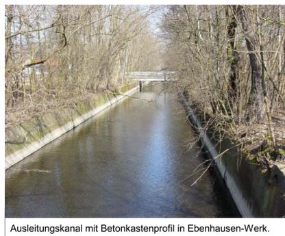
Ausleitungskanal mit Betonkastenprofil in Ebenhausen-Werk.
