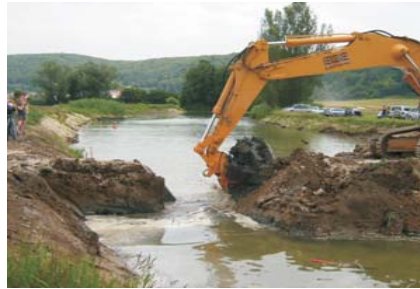
▲ Durchstich und Verbindung der bestehenden Altarme am 23.07.2009.
