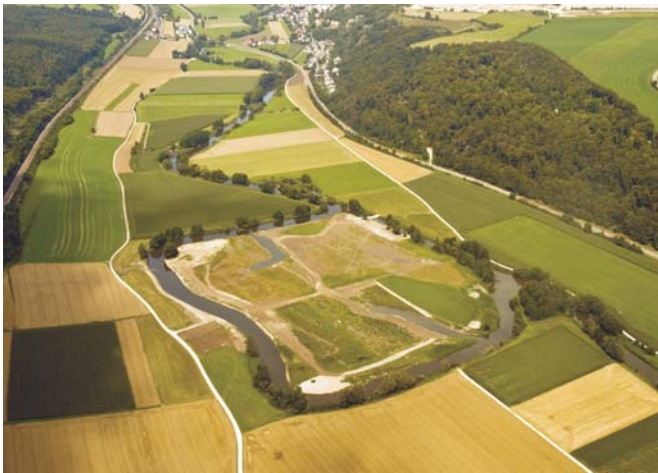
▲ Das Projektgebiet am 10.08.2009 nach Abschluss der Bauarbeiten.
