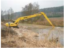
▲ Räumung und Aufweitung der Altarmprofile.
