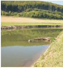
▲ Neuer Flussabschnitt mit Totholzeinbau zur Förderung der Strukturvielfalt.
