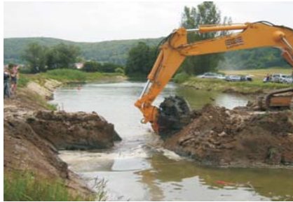
▲ Durchstich und Verbindung der bestehenden Altarme am 23.07.2009.
